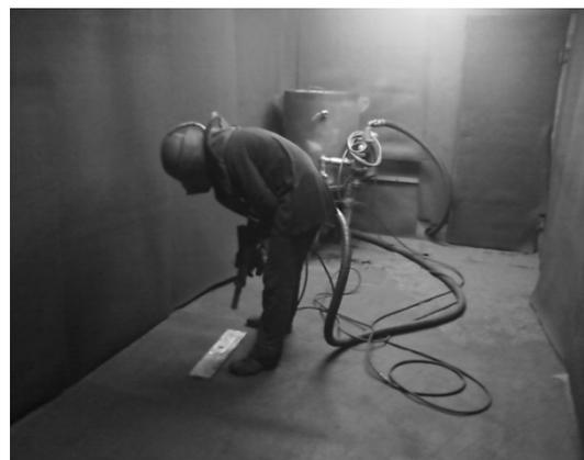
**Figure II-8.** L'opération de sablage.
