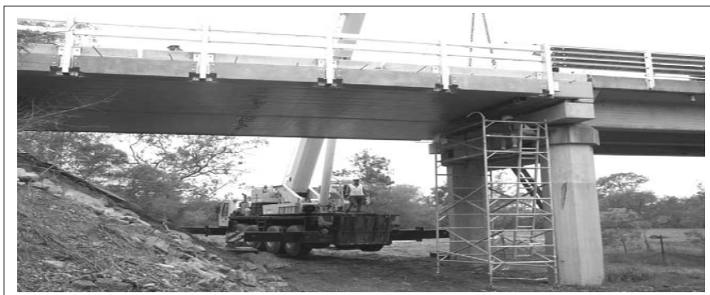
Figure I.19: Installation des premiers composites FRP "Australiens" sur pont [30].
