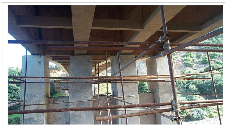
Figure II.20. Echafaudage des appuis du pont
