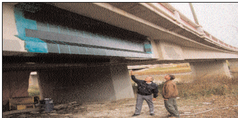
Figure I.8 : Renforcement d'un tablier de pont à poutres béton à l'aide de TFC.
