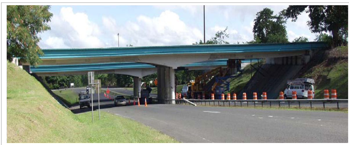
Figure III.25: Vue d'ensemble du "Pont 2028 on PR 52" avant sa réhabilitation [94].
