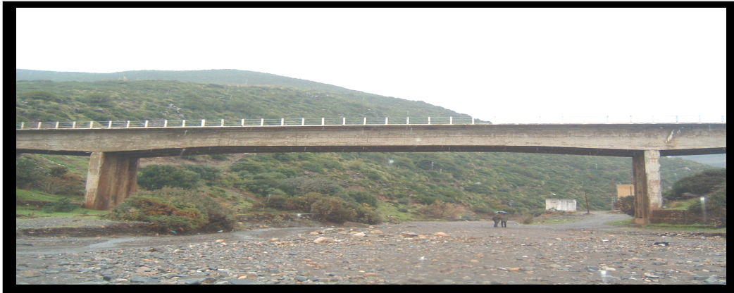
Figure II.17: Vue d'ensemble du pont "Oumazer"
