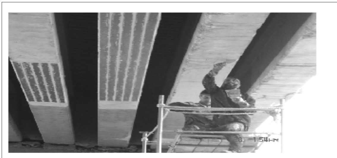
Figure I.22 : Pose de tissu en fibres de carbone sur les poutres du tablier [33]
