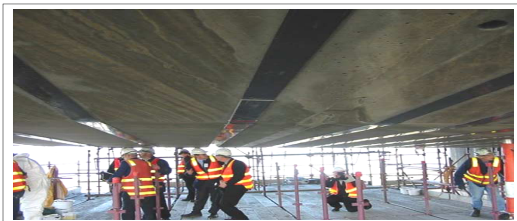
Figure I.20: Inspection du comportement du tablier du pont renforcé [30]
