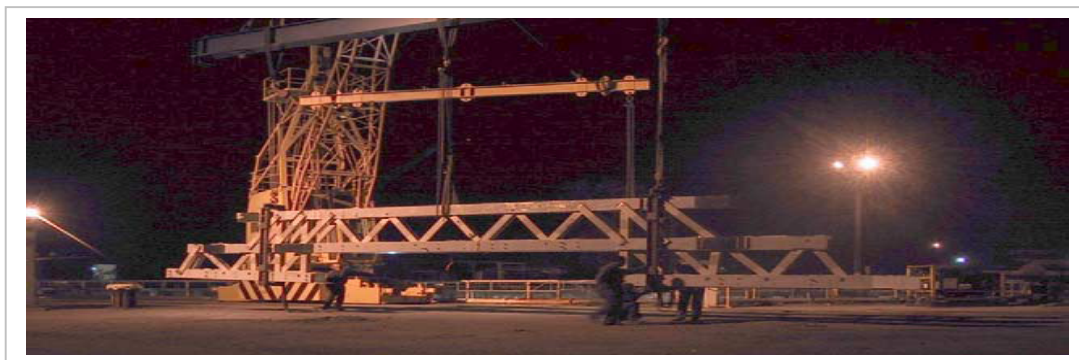
Figure I.18: Application des composites pour une nouvelle construction civile en treillis [27].
