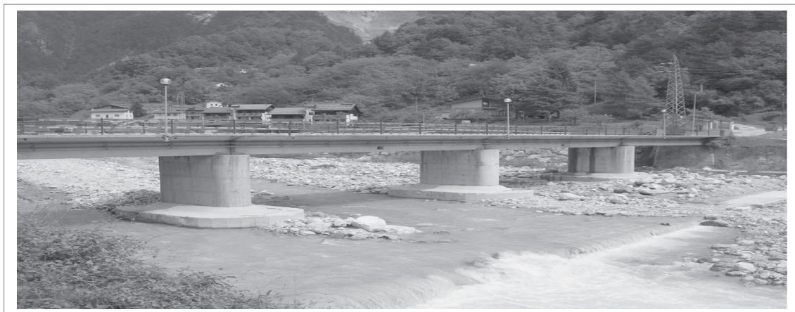
Figure III.32: Vue d'ensemble du Pont "Dogna" [97]
