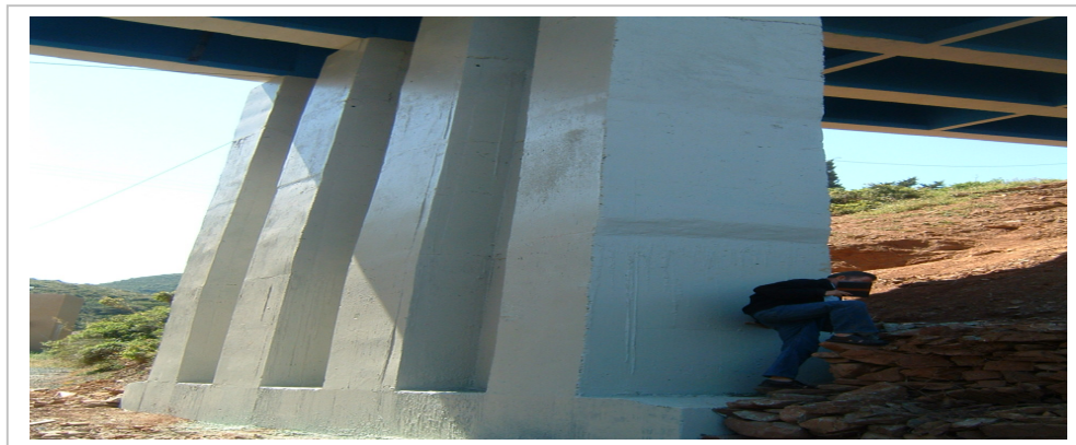
Figure II.23: Pile du pont après sa réparation
