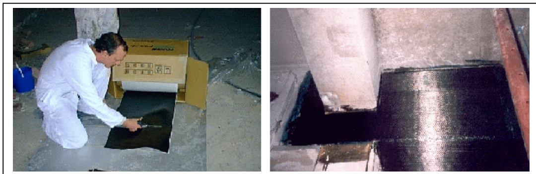
Figure I.17: Préparatifs pour placage des composites CFRP [27]
