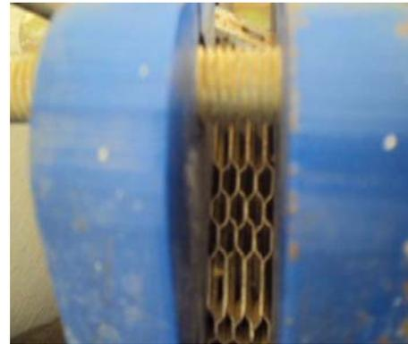
Figure 5.7 : Echangeur à plaques Ciatesa
