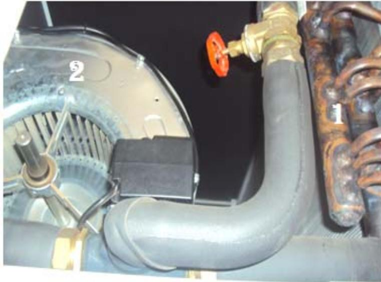
Figure 5.15 : Corps du ventilo-convecteur à l'intérieur
