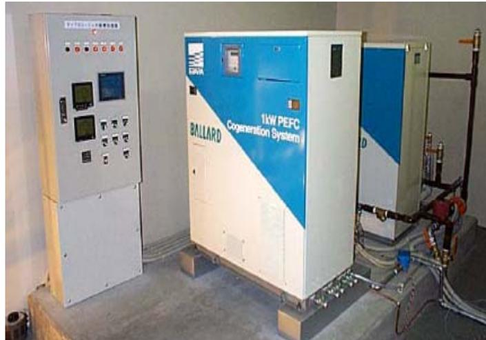
Figure 2.8: Cogénération par PEMFC alimentée au gaz naturel [53].
