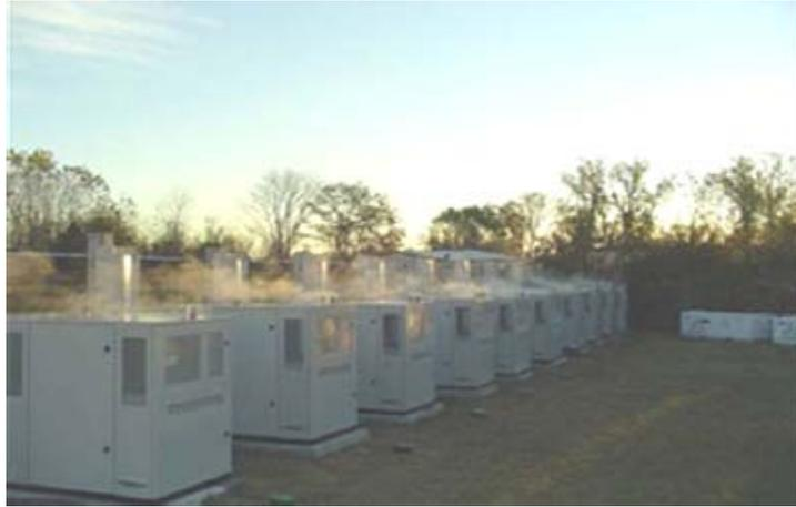
Figure 2.3 : Photo d'un système installé par GenSys™ pour la production d'énergie par PEMFC hors réseau [41]
