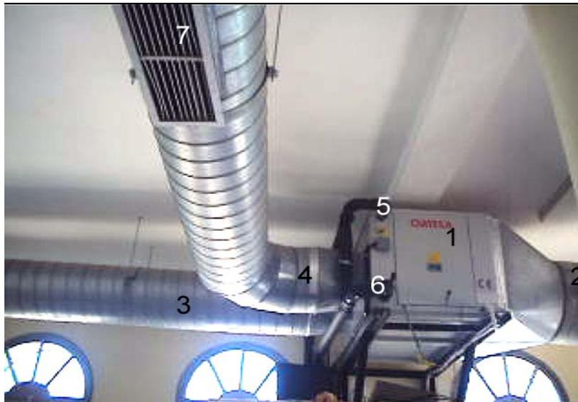
Figure 5.14: Principaux éléments du ventilo-convecteur placé dans la salle de cantine
