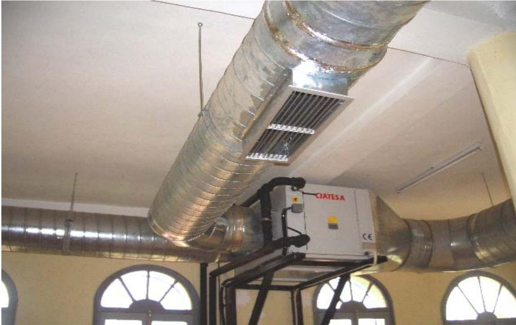
Figure 5.3 : Ventilo-convecteur dans la salle de cantine
