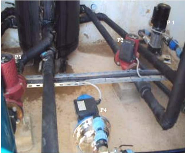
Figure 5.11 : Les pompes du circuit de récupération de la chaleur géothermique
