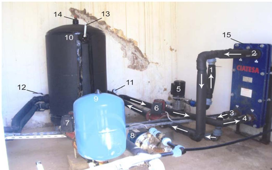
Figure 5.2 : Système de récupération de la chaleur géothermique
