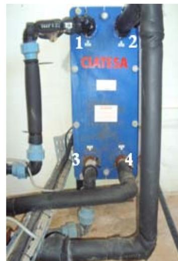
Figure 5.9 : L'échangeur à plaques de l'installation de climatisation de Saïda
