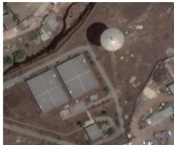
b. carte satellitaire de la station de pompage
