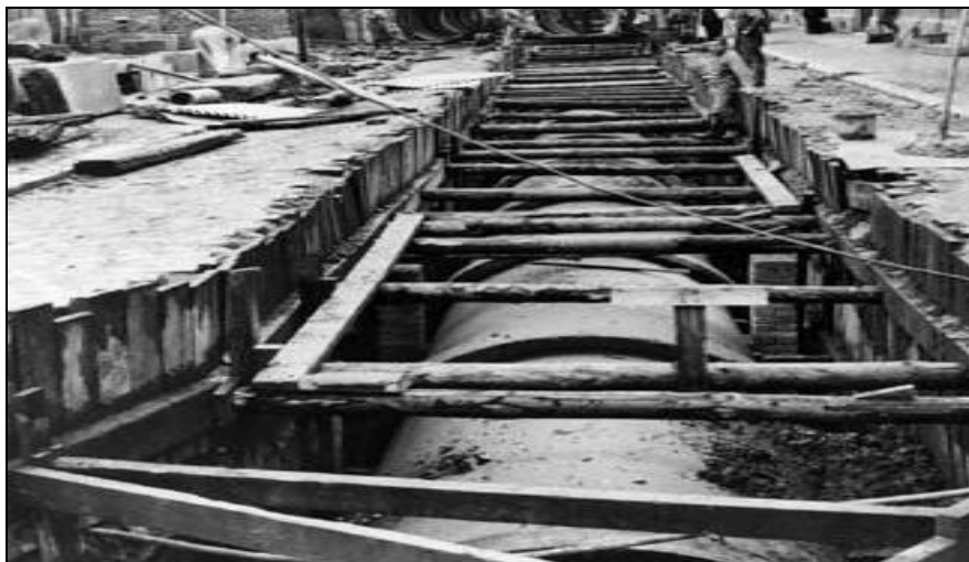
Photos 1.15 : Tuyaux en Béton utilisés pour les transports des eaux usées (Belgique).
