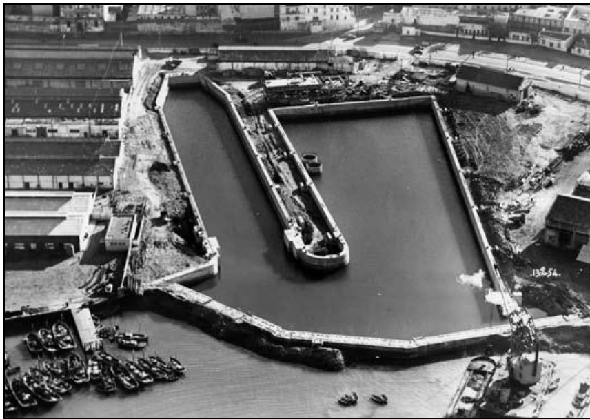
Photos 1.13 : Port de Casablanca (Maroc, 1954-55) Construction de la forme radoub et du bassin d'armement.
