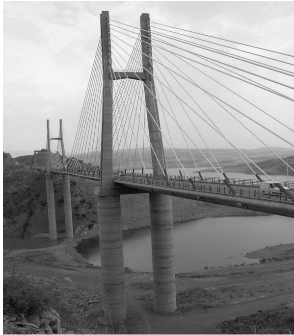
Figure VI. 1: Vue générale du pont à haubans sur l'Oued Dib à Mila
