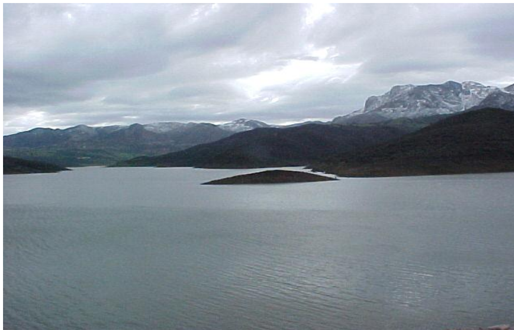
Figure IV- 1 : Photo du barrage de Keddara.
