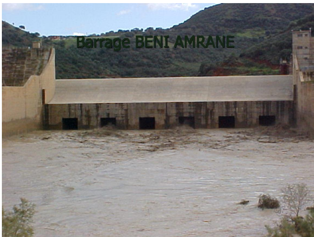
Figure IV- 2 : Photo du barrage de Beni Amrane.
