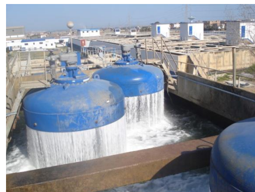
Figure IV- 5 : Photo des obturateurs.
