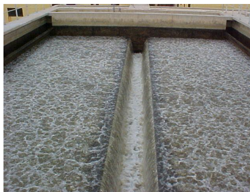
Figure IV- 10 : Photo du filtre en lavage.
