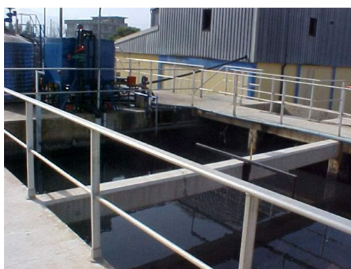
Figure IV- 6 : Photo du couloir de mélange.
