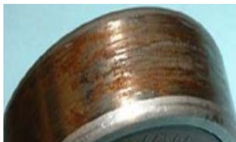
(a) Corrosion généralisée
