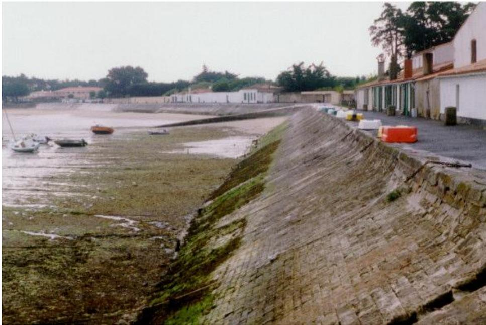
**Figure II.12** : Perré en maçonnerie datant du 19<sup>ème</sup> siècle. La Flotte-en-Ré, France.
