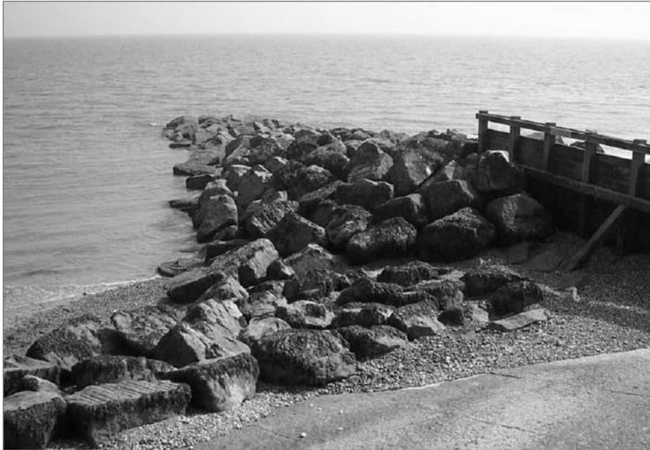
**Figure II.1** : Epi en enrochement classique. Source : Guide Enrochement.
