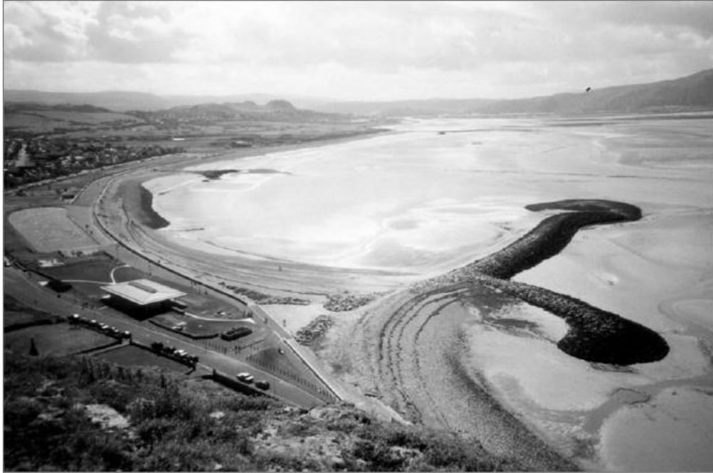
**Figure II.3** : Epi en Y. Source : Guide Enrochement.
