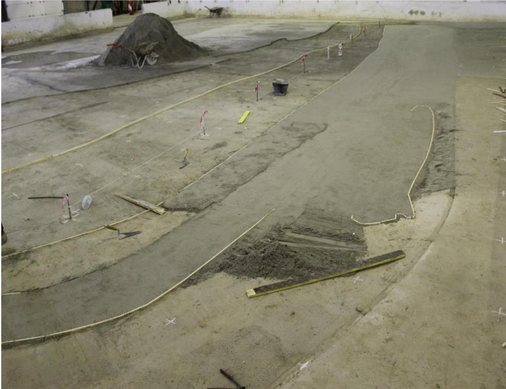
Photo III.2 : Construction des fonds du modèle réduit.
