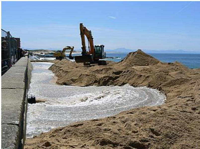
**Figure II.15** : Travaux de rechargement de plage à Capbreton, France.
