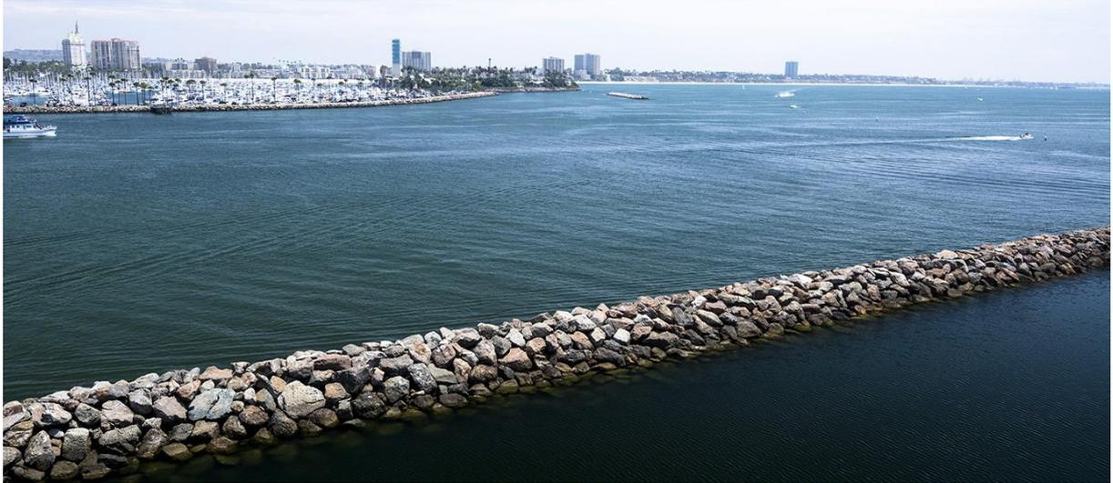
**Figure II.9** : Brise-lame en enrochement naturel. Perth, Australie.
