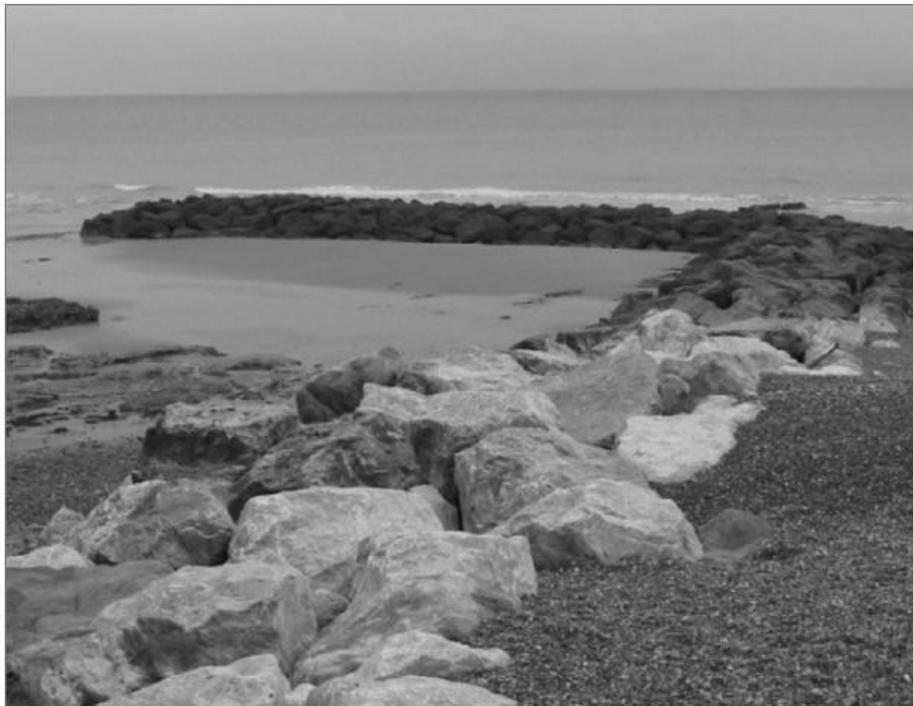
**Figure II.2** : Epi en L à Bulverhythe, Royaume Uni. Source : Guide Enrochement.
