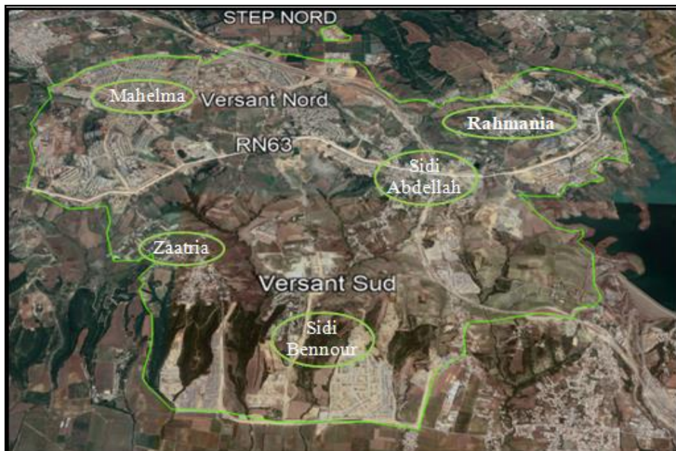
Figure 3-2 : Le site de la STEP Nord
