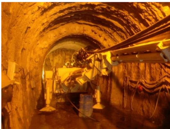
FIGURE A.2 – Excavation mécanique pour la réalisation du tronçon E2
