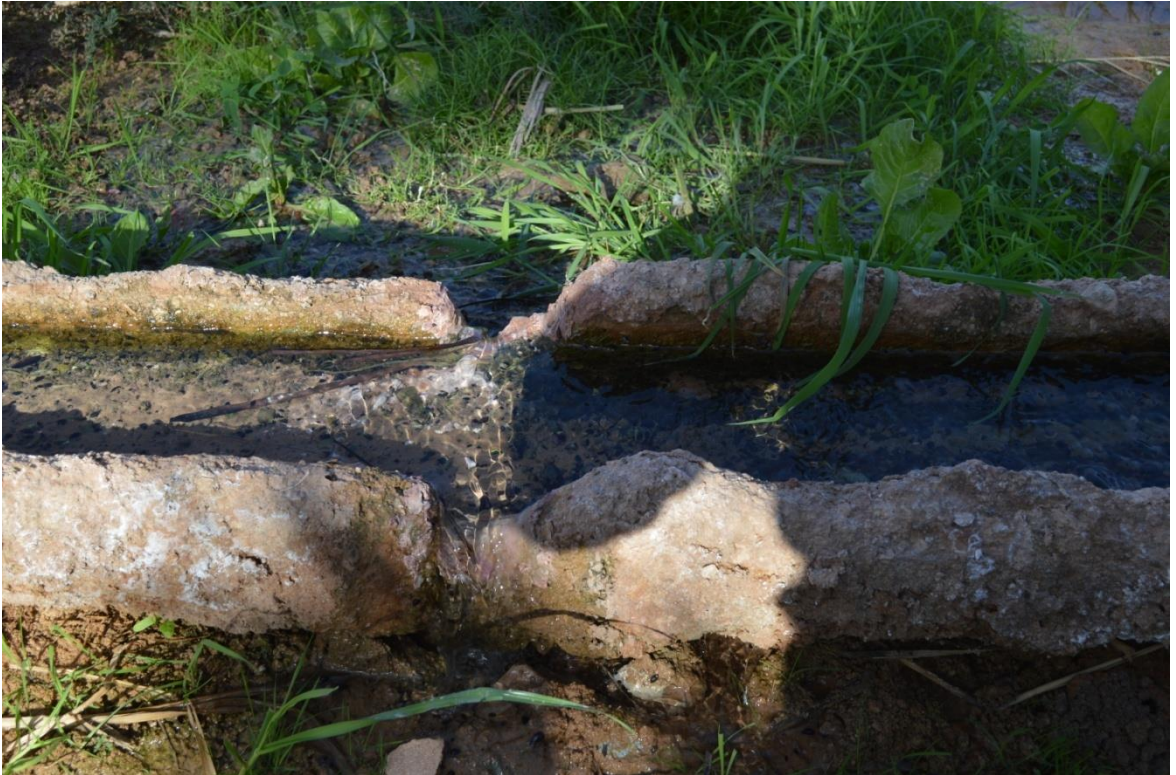
Photo 6-1: Segua de la foggara El Hadjadj [12]
