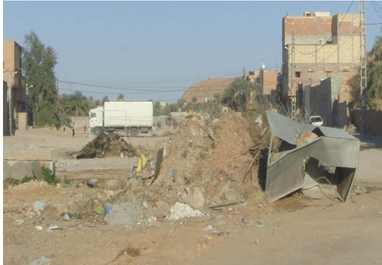
Photo IV-1 : présence des déchets solides et obstacles dans le lit de l'oued
