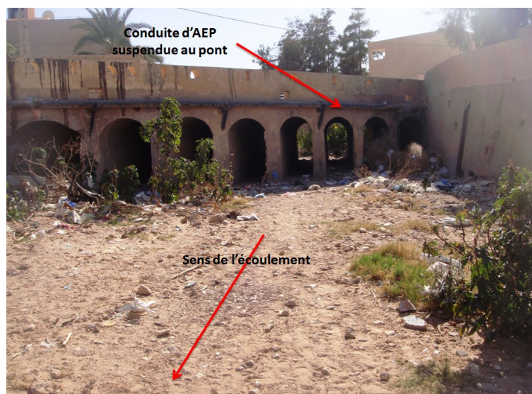
Photo IV-13 : côté aval du pont exutoire
