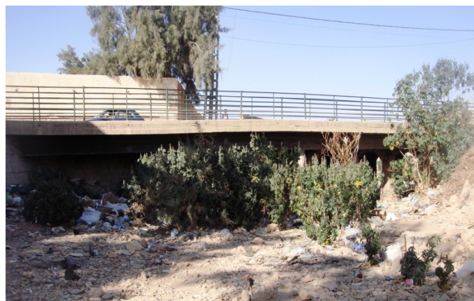
Photo IV-7 : végétation spontanée en amont du pont exutoire
