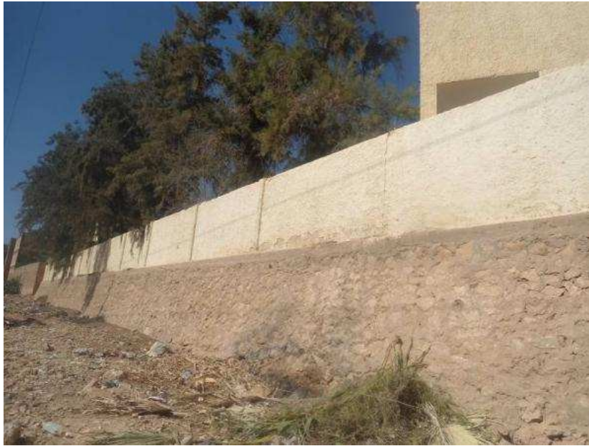
Photo IV-8 : mur de protection en pierre
