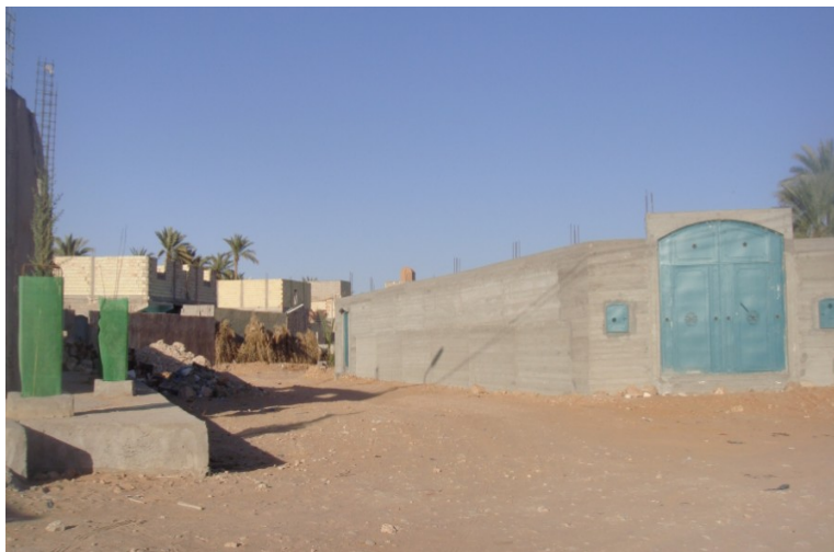
Photo IV-2 : constructions anarchiques dans le lit du cours d'eau
