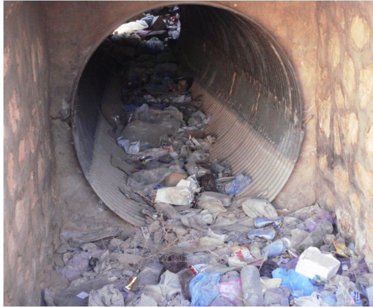
Photo IV-12 : buse pleine de déchets et sachets en plastiques
