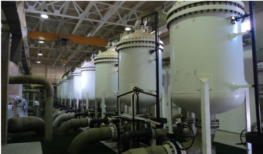
Figure II. 7: L'unité des filtres à cartouches, (Meradji, 2015).
