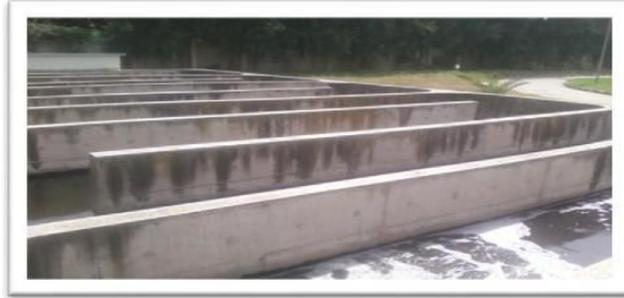
**Figure III.9 : Bassin de chloration.**
