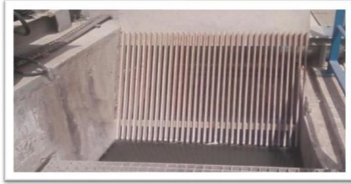
**Figure III.5 : Dégrilleur du type à champ courbe.**
