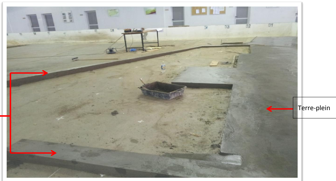
Figure VI.4 : photo montrant la construction des quais et du terre-plein.
