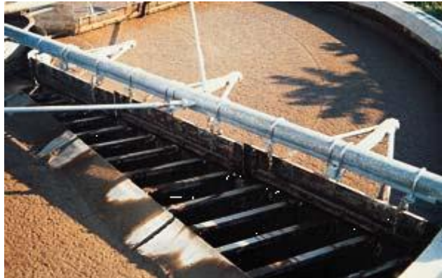
Figure II.7: Epaississement des boues
