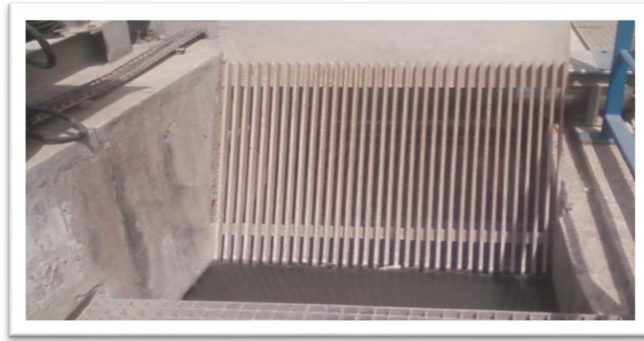
Figure IV.5 : Dégrilleur du type à champ courbe.
