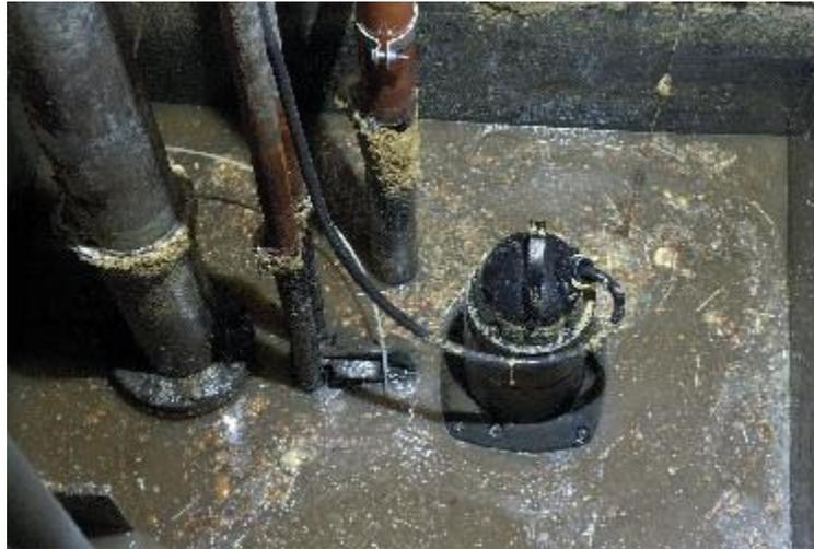
*Figure VIII-1 : Puisard dans un poste de relevage.*
