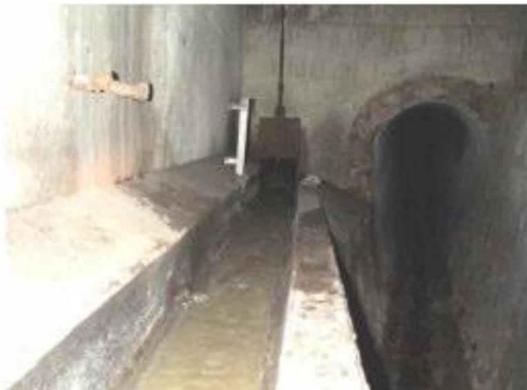
*Figure VII-6* : Exemple de déversoir à seuil simple.
