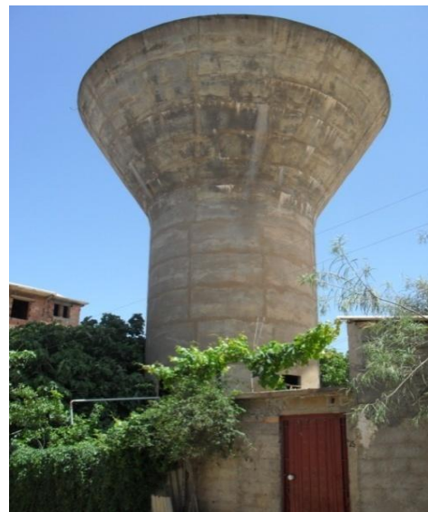
Photo V-8 : Réservoir 300m 3
