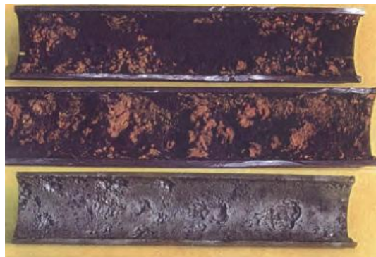
Photo II-1 : Corrosion de l'intérieur [ Bradosche , 2011]
