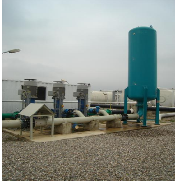
Figure 4 : Réservoir anti-bélier.
