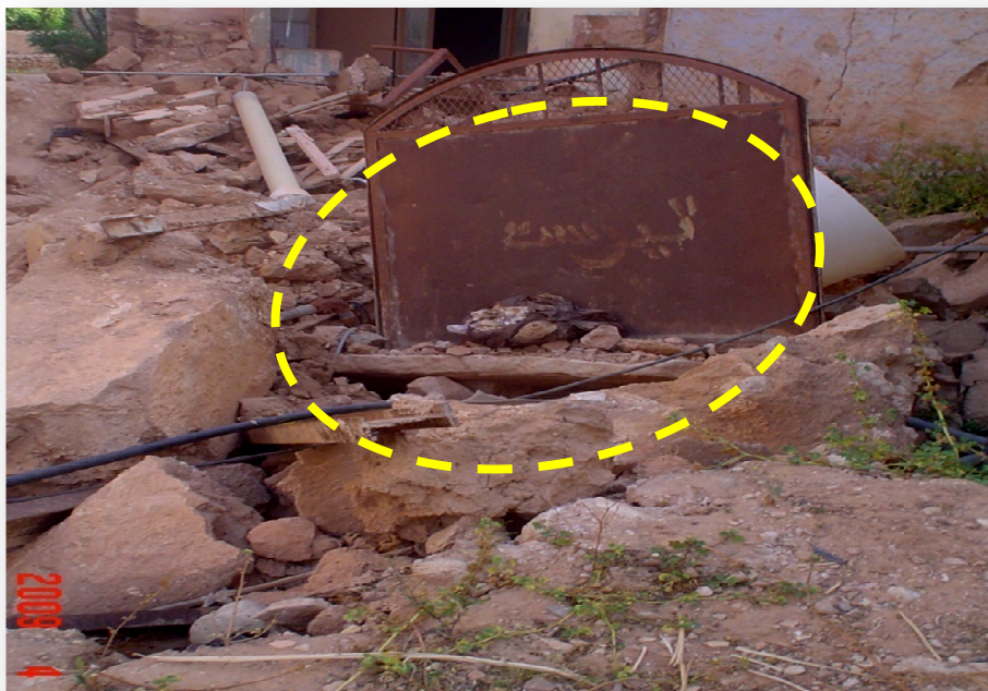
Photo III-1 : Puits endommagé par la crue Octobre 2008.
