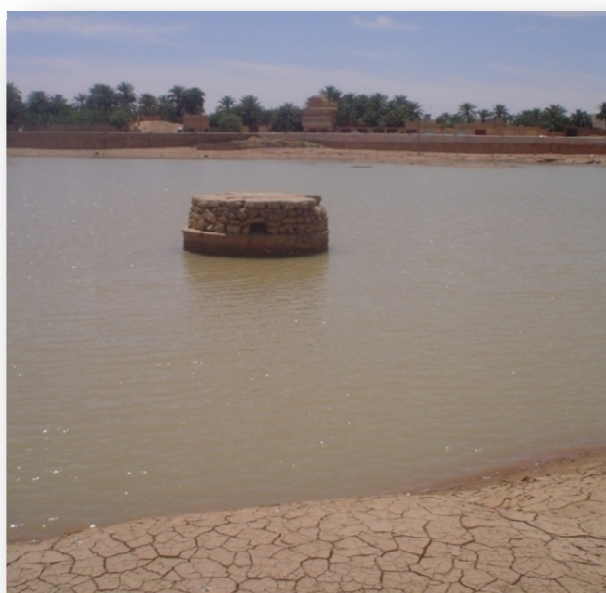
Photo II-8 : Un puits capteur dans la retenue de barrage Bouchène .
