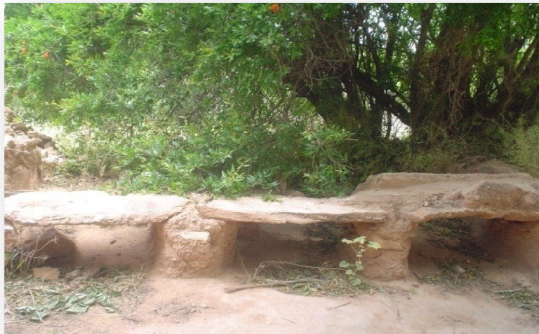
Photo II-16 : Trop-plein d'un jardin (dans une zone non urbanisée).
