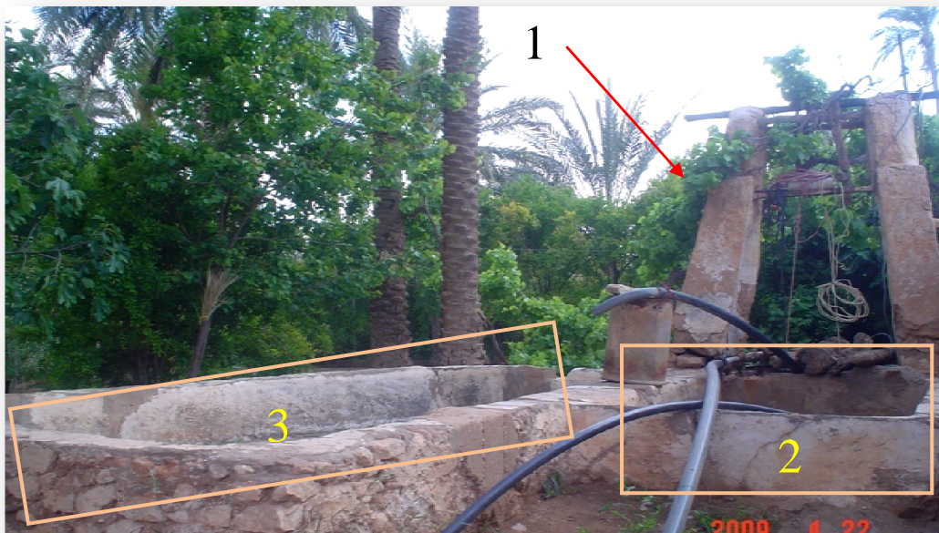
Photo II-17: Le système de puisage (1. puits, 2. Assefy, 3. Madjel).
