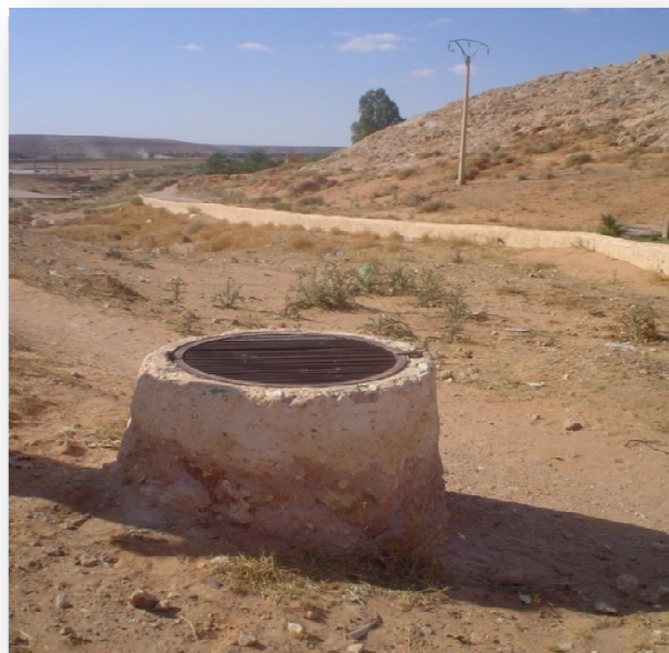
Photo II-10: Les puits d'aération.
