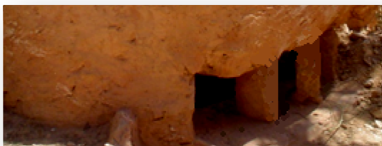
Photo IV-1 : Les orifices d'un puits capteur.
