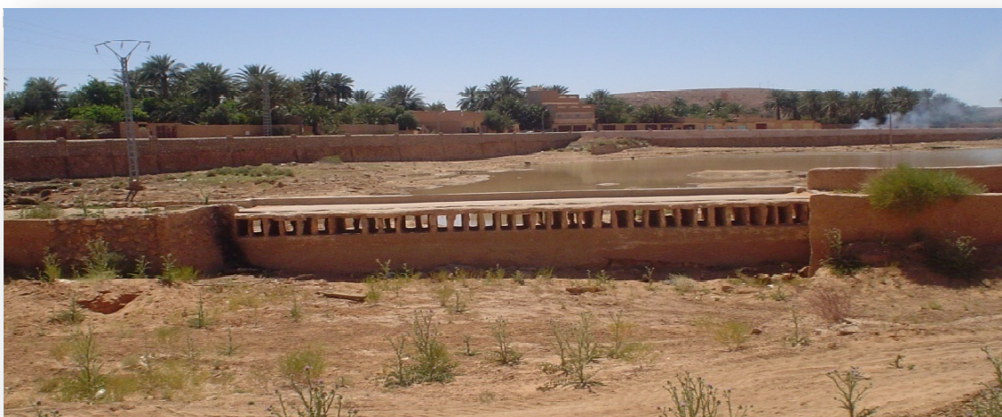
Photo II-5 : Déversoir de canal Bouchemdjene vers le barrage Bouchène .
