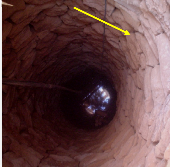
Photo III. 4: Puits avec des matériaux locaux.
