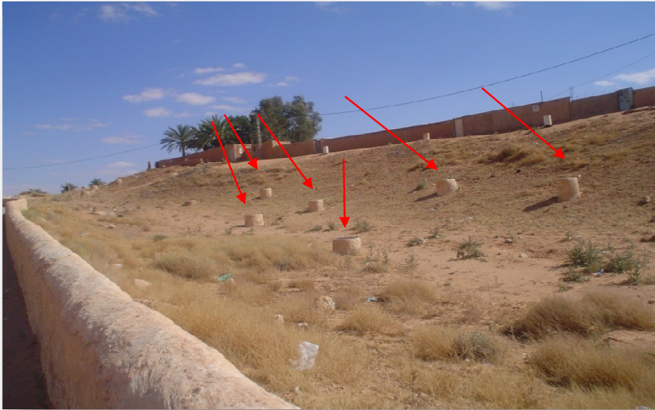
Photo II-10: Les puits d'aération.
