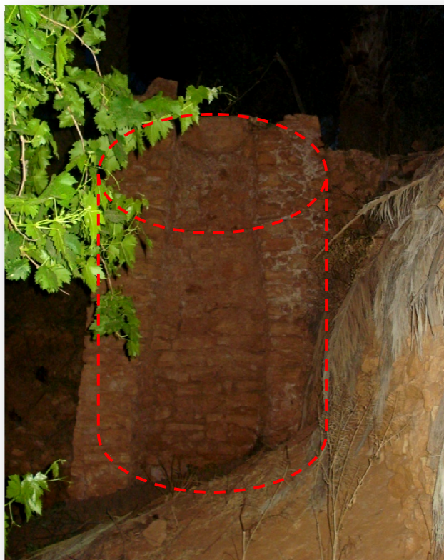
Photo II-21: Un puits de transfert d'eau de puisage "Adjem".
