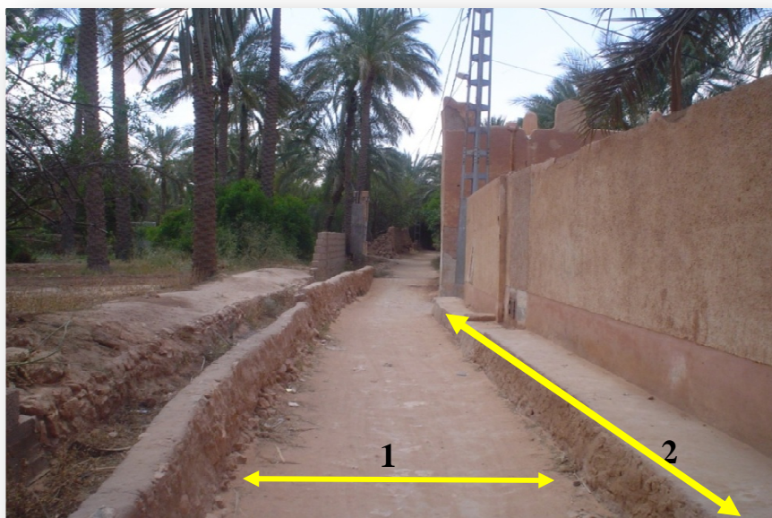
Photo II-13 : 1. Canal à ciel ouvert, 2. Voies de secours en période de crue.
