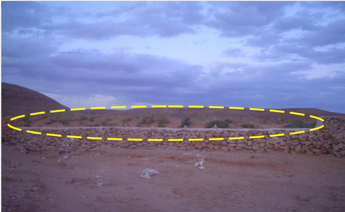
Photo II.4 : Déversoir de canal Bouchemdjene vers canal Bouchène .
