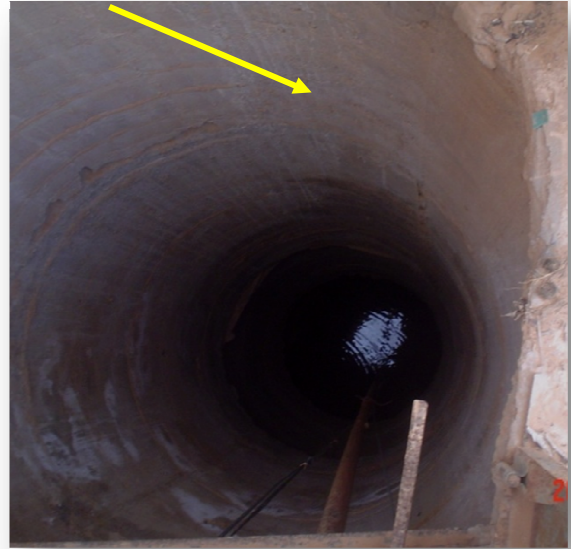
Photo III. 5: Puits en pierre réhabilité en mortier.
