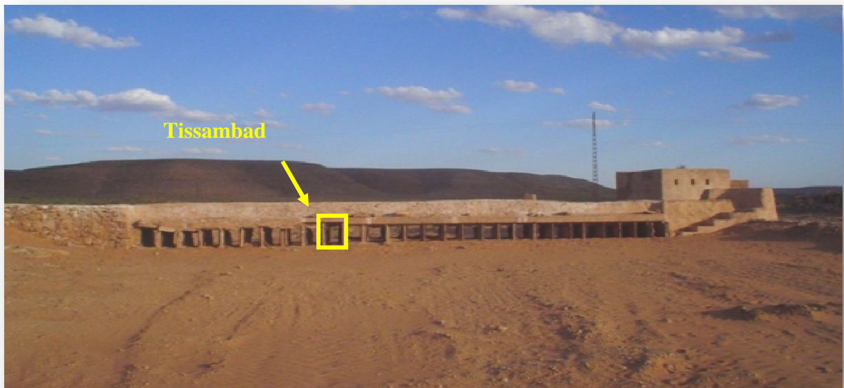
Photo II-2 : Les Tissambads de régulation de canal Bouchemdjene.
