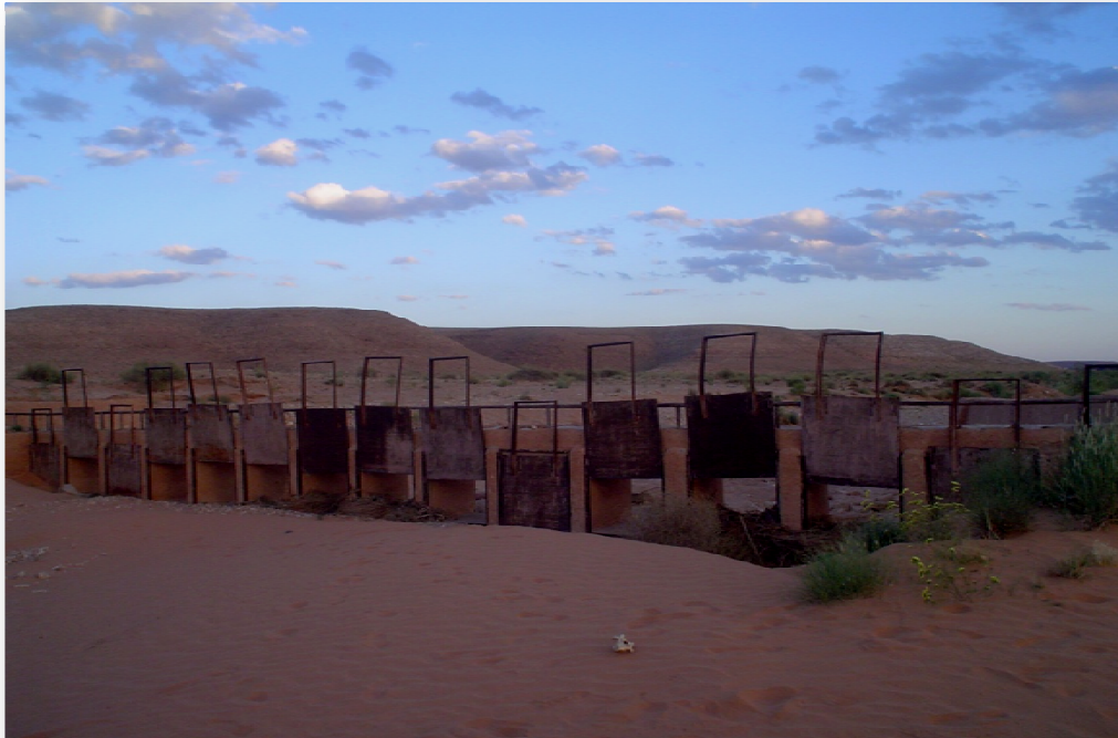
Figure X : Les Tissambads du canal de Bouchène
