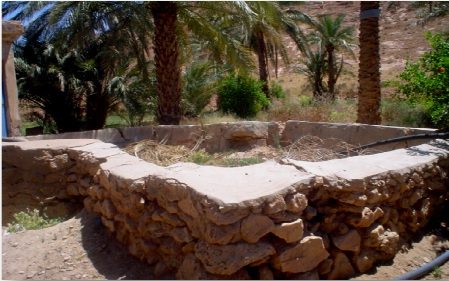
Photo II-22: Bassin de récupération d'eau "Madjel".
