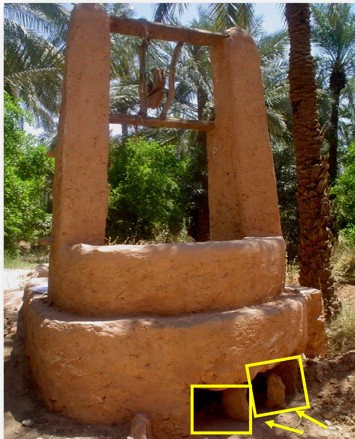
Photo II-20: Un puits capteur.
