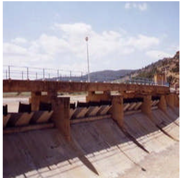
Figure III-20 : Photo des Hausses fusibles du barrage de Foum El Gueiss.
