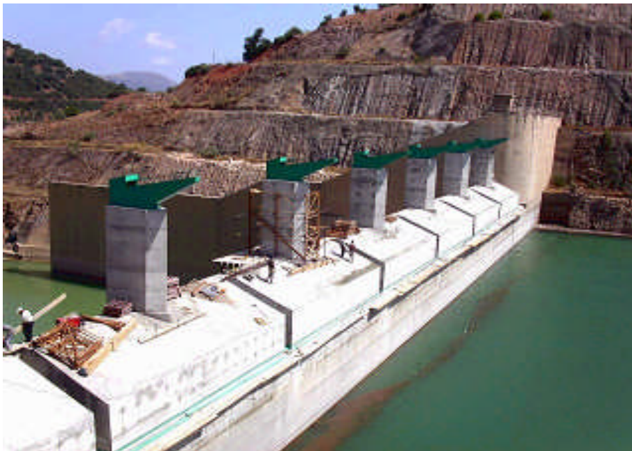
Figure V-12 : Photos des hausses fusibles du barrage du Béni-Amrane.
