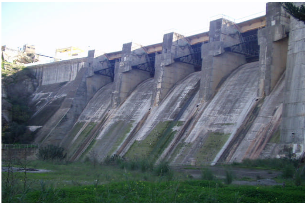
Figure III-8 : Photo du barrage de K'sob.
