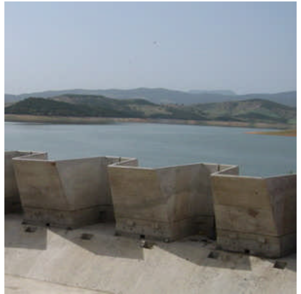
Figure III-21 : Photo des hausses fusibles du barrage de Ghrib.
