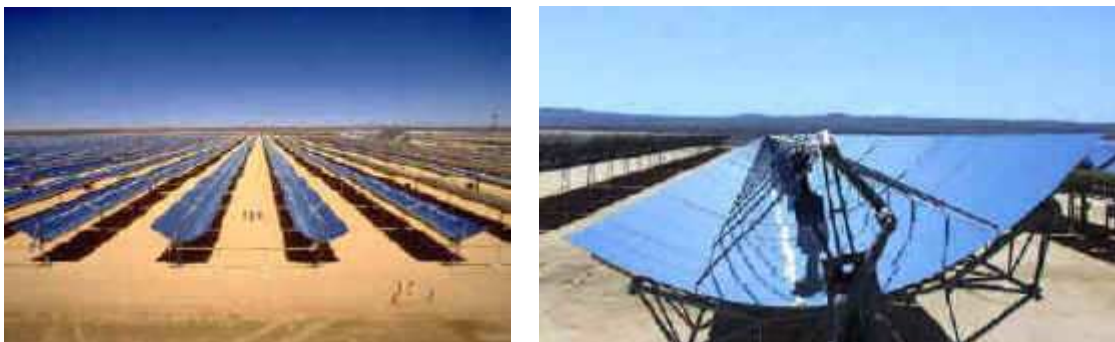
Figure 2.13: Concentrateurs solaires utilisés pour la centrale hybride gaz-solaire
