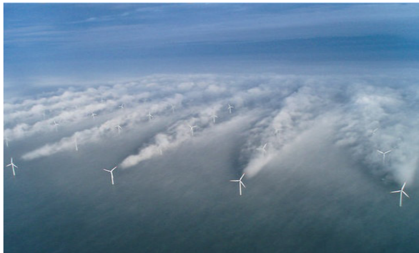
Fig. 2.2 Effet de sillage dans un parc éolien
