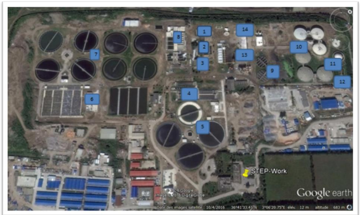
Figure4.1. Une photo prise de google earth de la station d'épuration de Baraki
