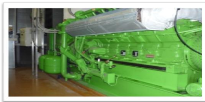
Figure 2.8. Cogénération moteur à gaz, (N. Bachmann, 2012)
