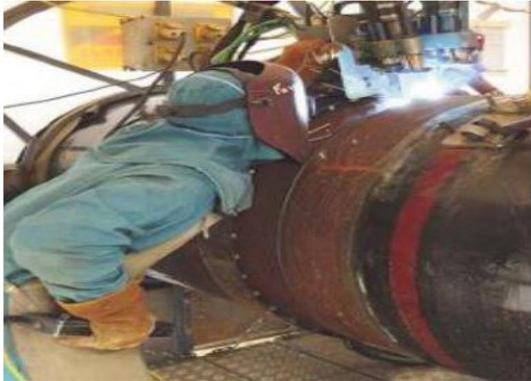
Figure II-3 : Soudure des tubes
