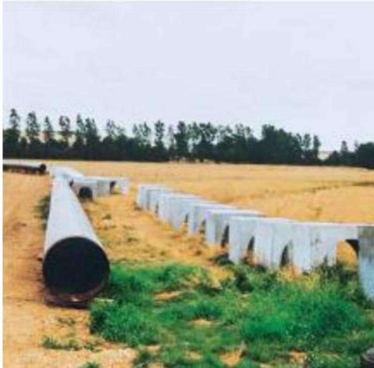
Figure II-6 : Cavalier de lestage en béton bardés
