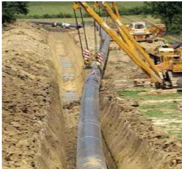
Figure II-5 : Mise en fouille des tubes
