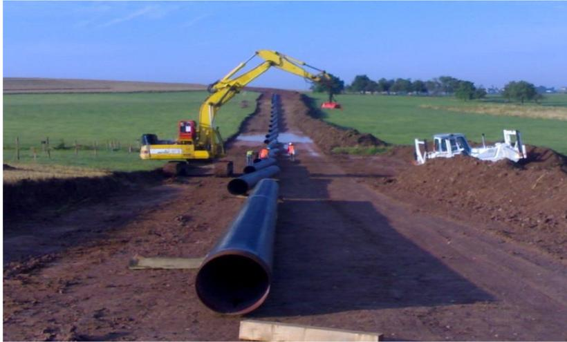
Figure II-1 : Bardage des tubes
