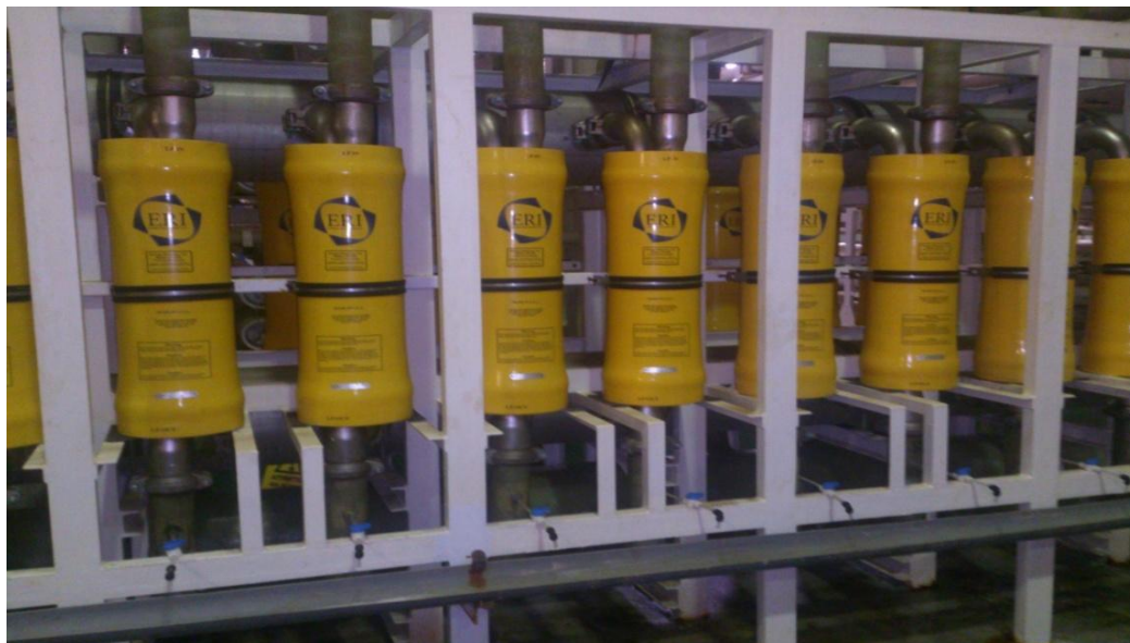
Figure II.8 : Le système de récupération d'énergie (ERI) (Fouka, 2015)
