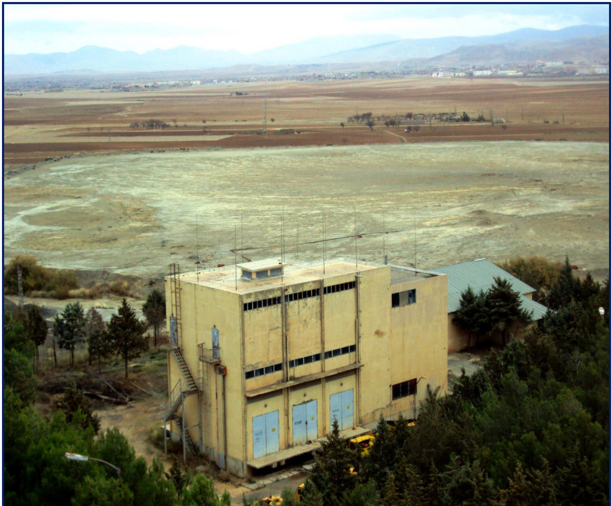
Figure 8 : Vue de la digue des stériles (ENOF, 2010)
