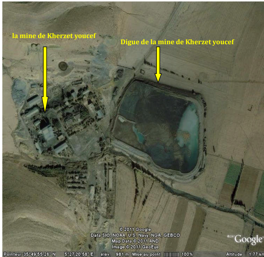
Figure 9.a : Digue de la mine de Kherzet Youcef (image par Google Earth)
