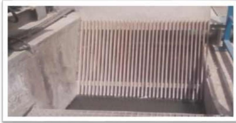
**Fig. II.4 : Dégrilleur du type à champ courbe.**
