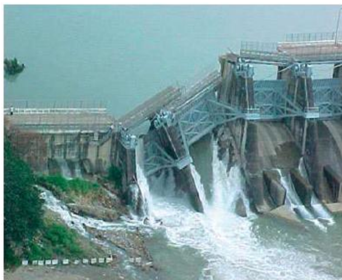
Fig.II.11 : Rupture du barrage ShiKang. [RAP]
