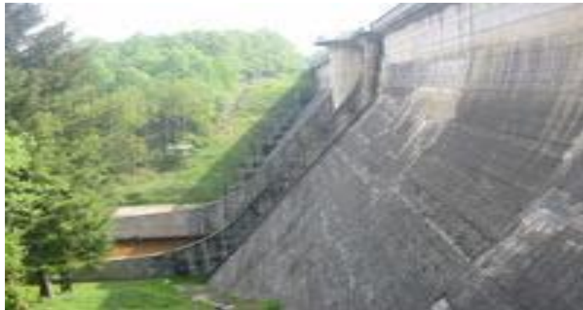
Fig.I.2 : Barrage de Vassivière. [SIT]
