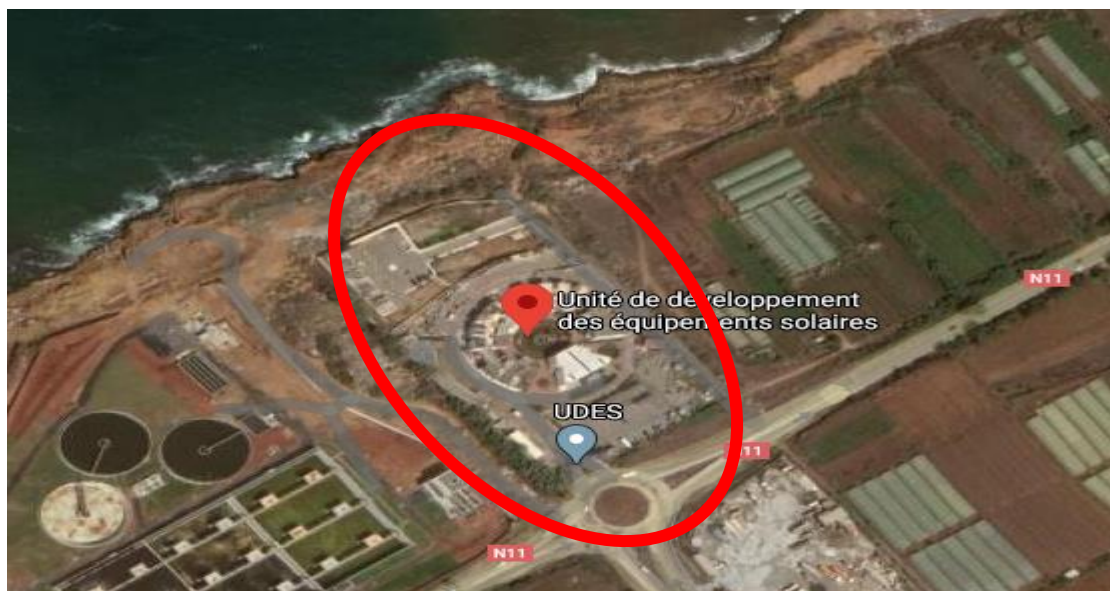
Fig. 3.23. l'Unité de Développement des Equipements Solaires (UDES) (Photo satellitaire).
