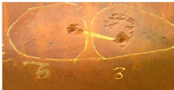
Figure 1-g : Pics de corrosion (localisée)
