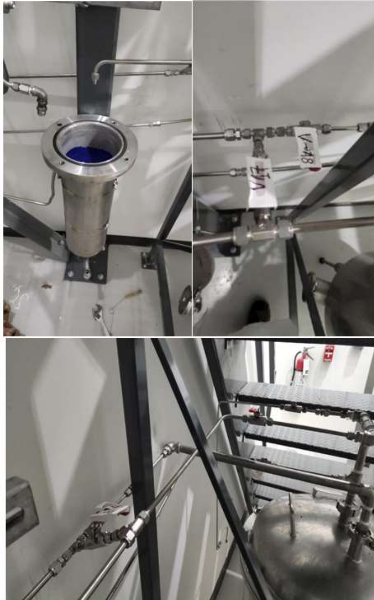
Figure 3. 13 Bypass du bain de glycol.
