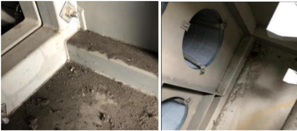
FIGURE 3.4 – Les impuretés présentes sur le côté propre
