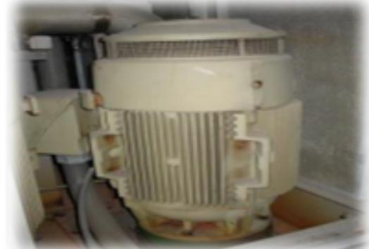
FIGURE 1.13 – Pompe de graissage 88QA-1      FIGURE 1.14 – Pompe de graissage 88QA-2
