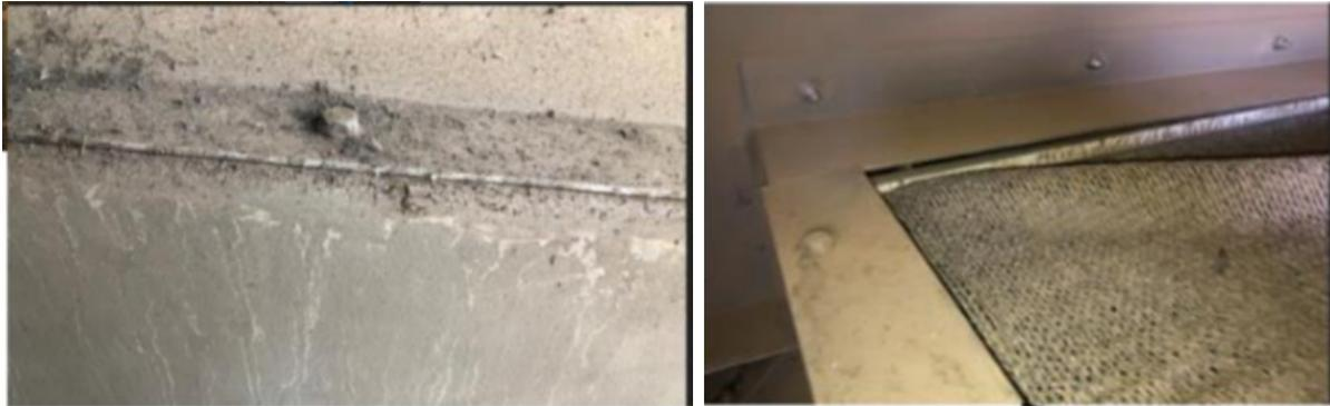
FIGURE 3.2 – Des impuretés déposées sur les surfaces de filtres
