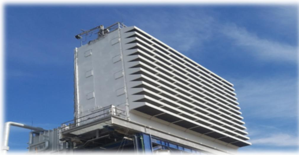
FIGURE 1.3 – Compartiment du filtre d'admission
