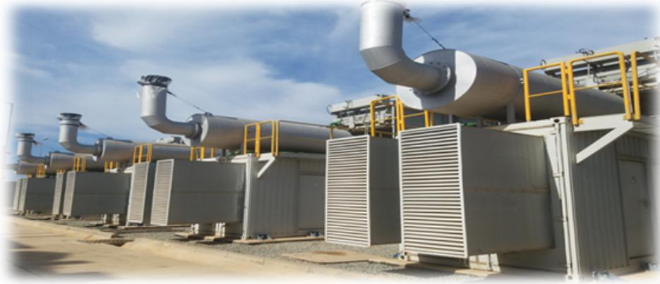
FIGURE 1.19 – Diesel de secours
