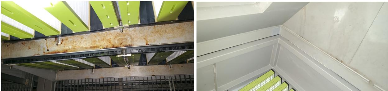
FIGURE 3.5 – Les gouttelettes d'eau présentes dans le côté propre
