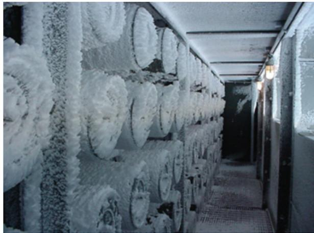
FIGURE 2.6 – Filtres à cartouche à impulsions avec formation de givre [4].
