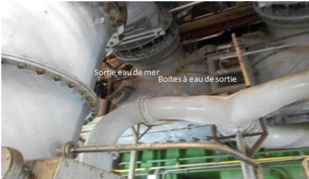
Figure V.2: Boîtes à eau de sortie
