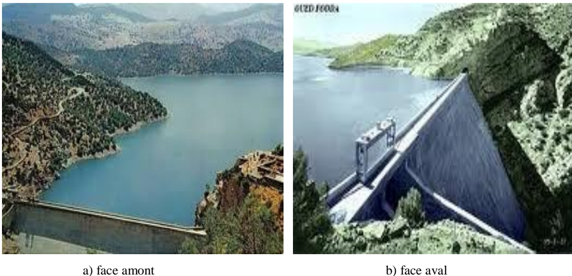
Figure 5.1 Barrage-poids en béton de Oued Fodda
