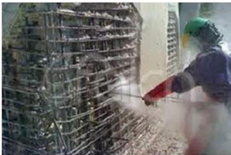
Figure 1.4 : Démolition par jet d'eau [3]
