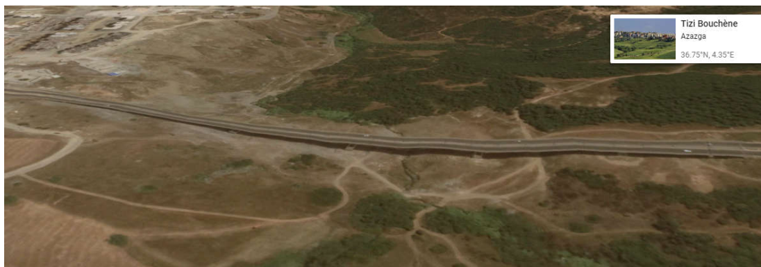
Figure I-2 : Photo du pont prise par Google Earth
