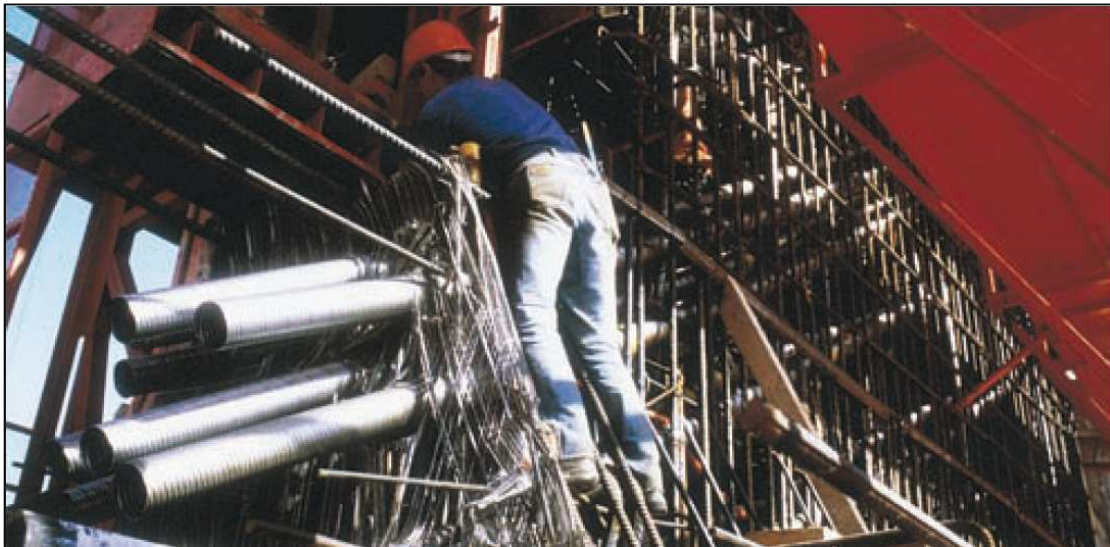
Fig .VI.3. Installation des gaine pour la post-tension
