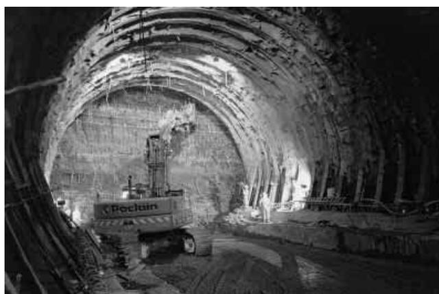
**Figure II.1.** Creusement à Pleine section
