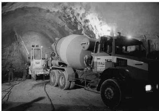
**Figure II.12 :** Béton projeté
