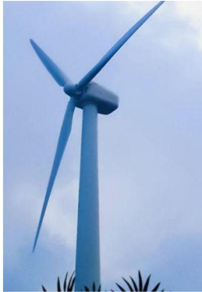
**Fig. 1.2 Eoliennes à axe horizontal.**
