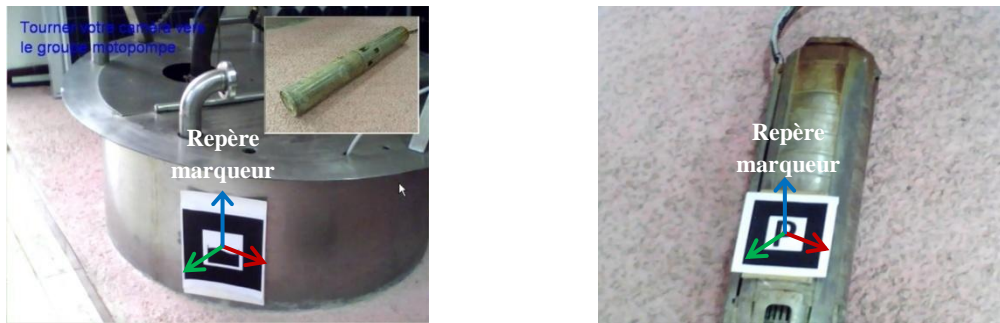
a. Marqueur de taille d=100\text{ mm} collé sur le puits b. Marqueur de taille d=80\text{ mm} collé sur la pompe Figure 4.16. Marqueurs collés sur des composants du système de pompage PV.
