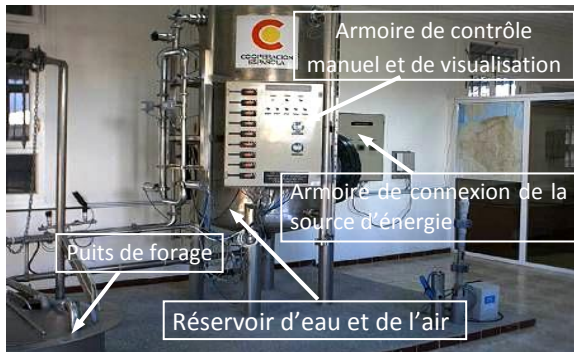
Figure 4.14 Système de pompage
