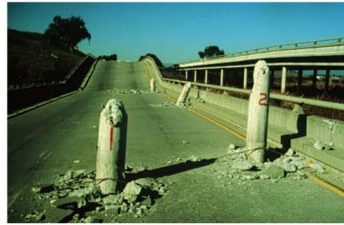
(b) Vue rapprochée du colonnes.
