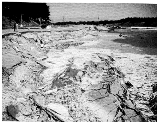
FIGURE 1.5: La nature fluide du sol liquéfié tout au long le bord du lac Merced, San Francisco 1957.[2]
