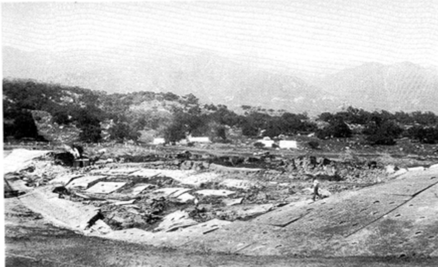
FIGURE 1.4: Liquéfaction du barrage de Sheffield après le seisme Santa Barbara, 1925.[2]
