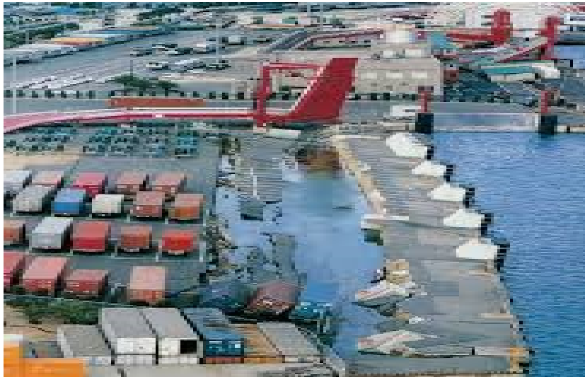
FIGURE 1.4: Séisme de Hyogo-ken Nanbu, Kobe, Japon, 1995.
