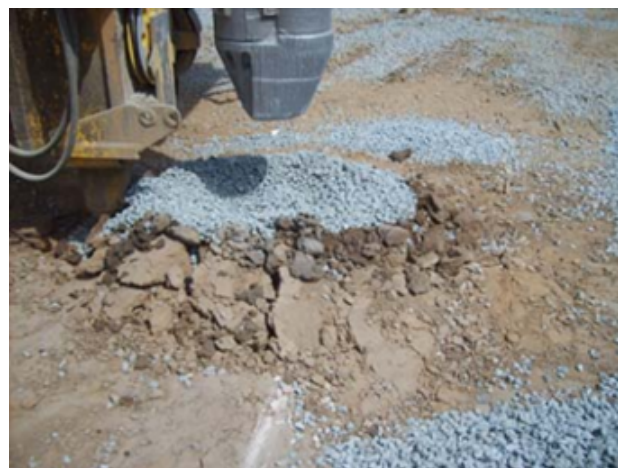
FIGURE 3.4: Une colonne de ballast après la finition .
