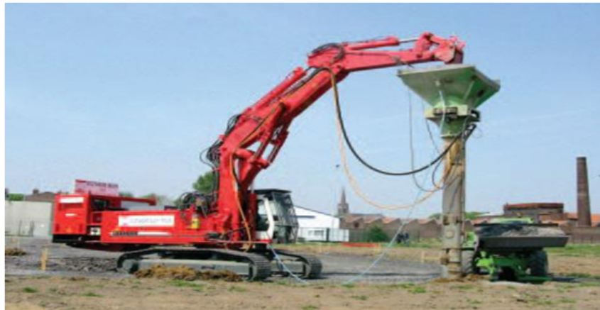
FIGURE 2.8: Colonnes ballastées.[9]
