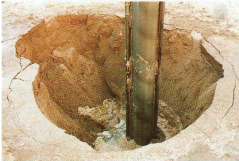
FIGURE 2.10: Le cône d'affaissement autour du vibreur
