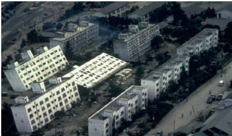
FIGURE 1.1: Inclinaison des bâtiments d'appartements de Kawagishi-cho à Niigata au Japon dues à la liquéfaction .
