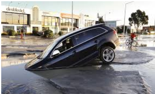
(a) Véhicule enlisé dans des ébullitions du sable, après le tremblement de terre à Christchurch, New Zealand (2011).
