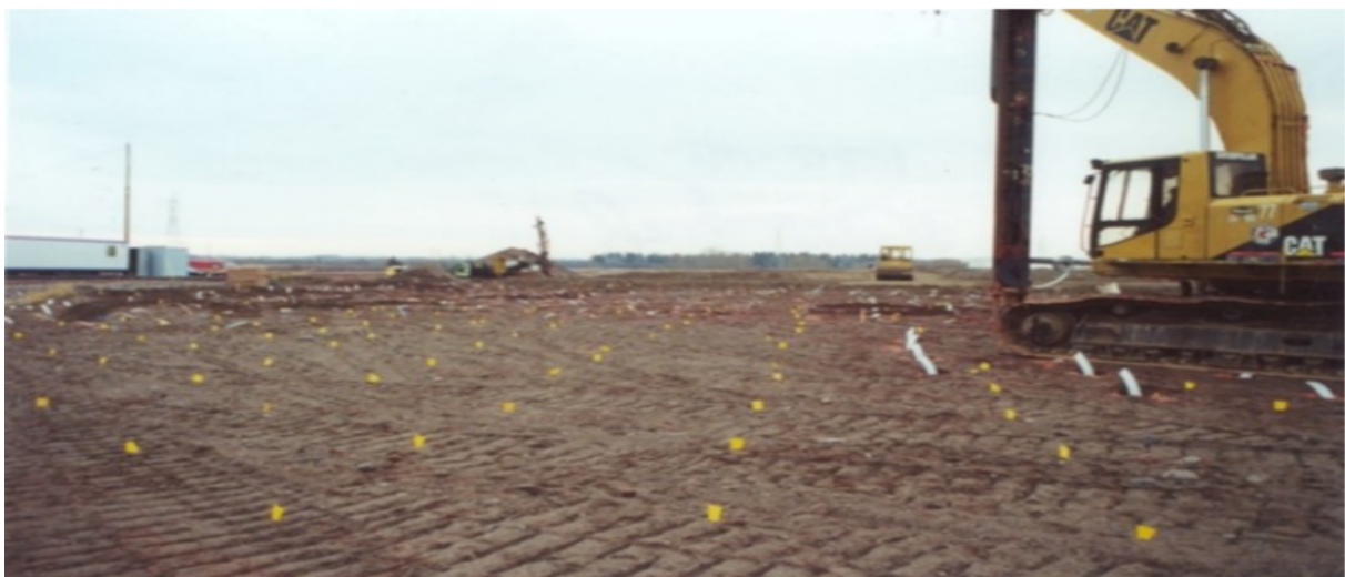
FIGURE 2.5: Chantier de réalisation des drains verticaux.
