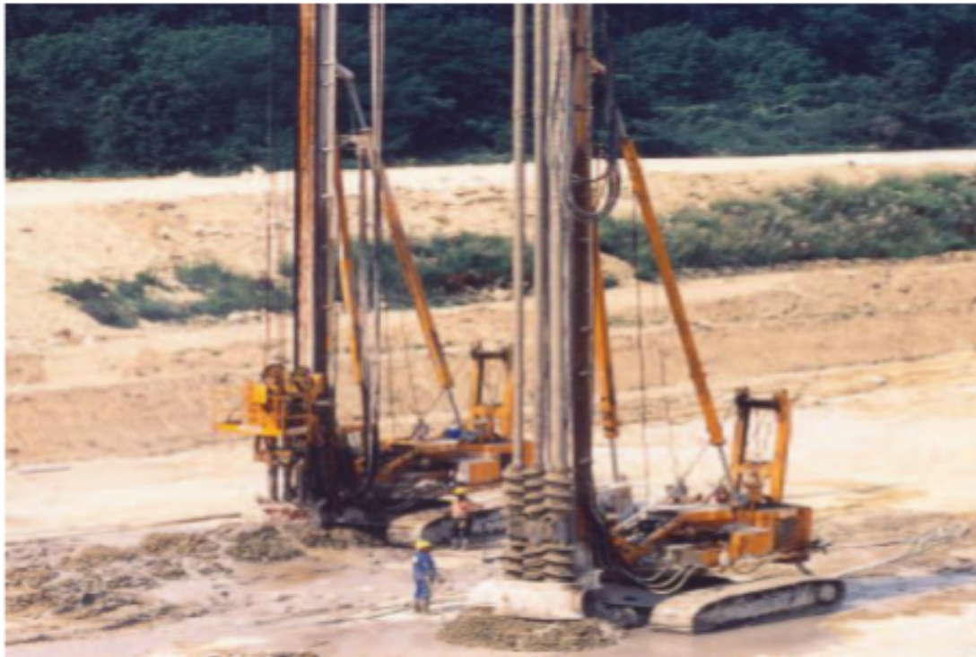
FIGURE 2.13: Amélioration de sol par soil mixing.
