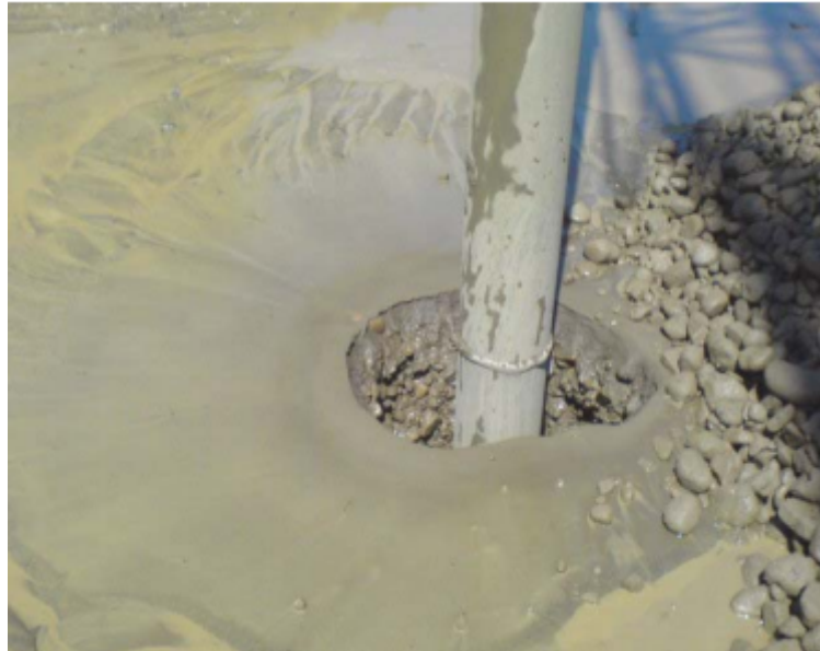
FIGURE 3.7: Phénomène de liquéfaction local (Site : barrage Kissir- Jijel).
