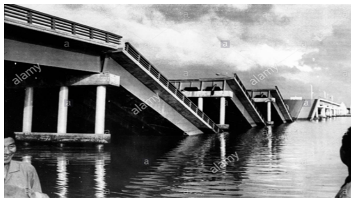
FIGURE 1.2: Rupture du pont de Showa, à Niigata au Japon, dues à l'épandage latéral dans le sol.
