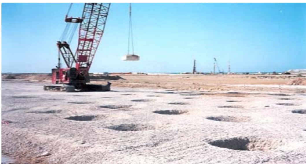
FIGURE 2.3: Exemple du site subissant une amélioration des sols par compactage dynamique.
