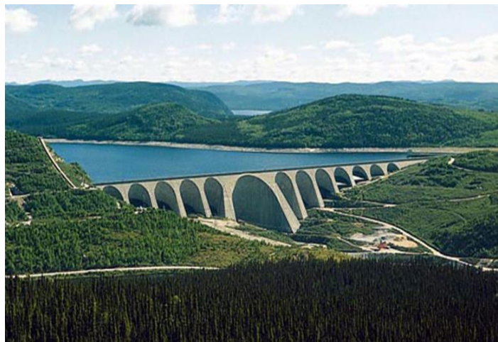
Figure 1.3 Barrages à contreforts
