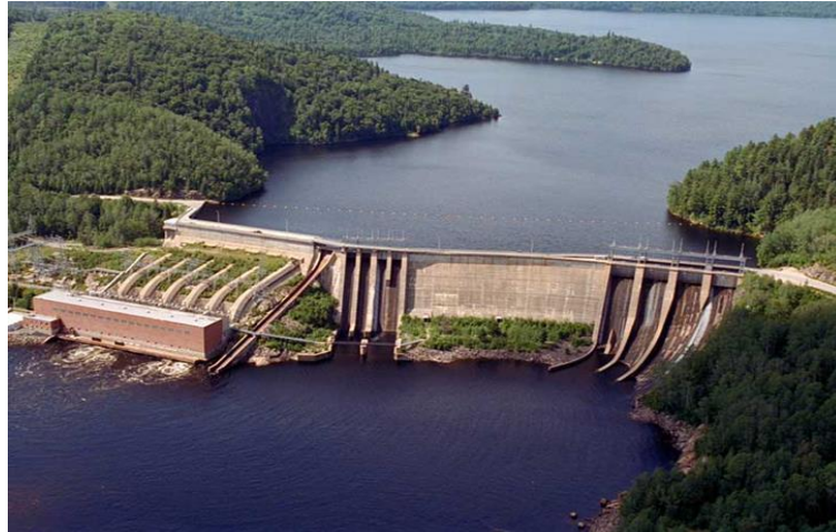
Figure 1.1 Barrage poids
