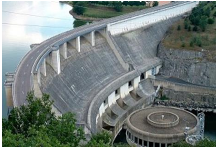
Figure 1.4 Barrage mixte (poids- voûtes)
