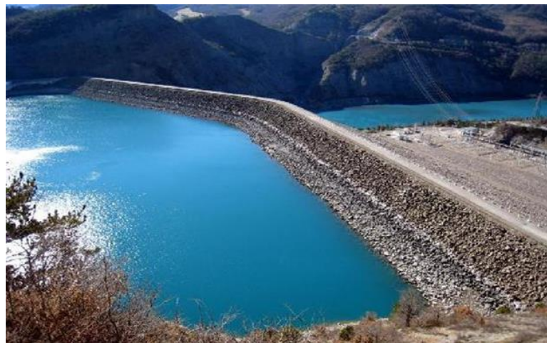
Figure 1.5 Barrage homogène
