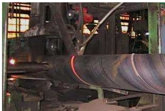
Figure IV. 4 : Réalisation d'une soudure spirale sur tube API.
