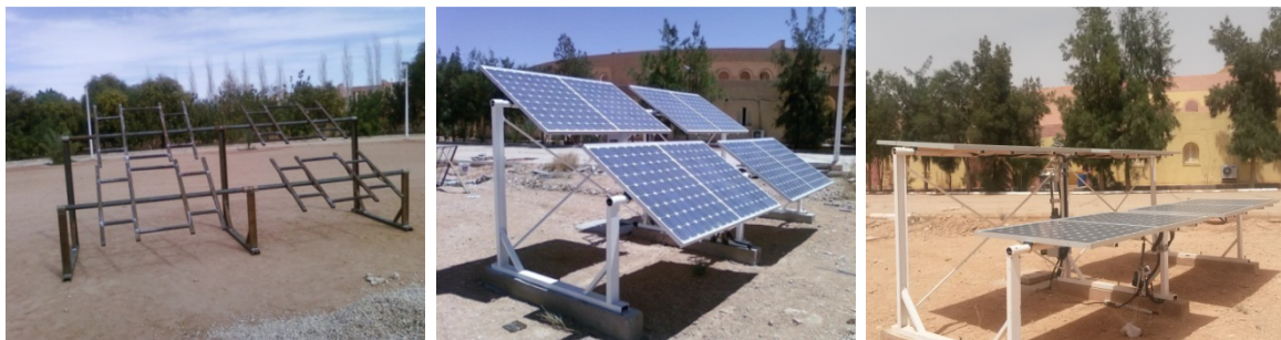
Figure III.18: Réalisation du support des modules photovoltaïques.
