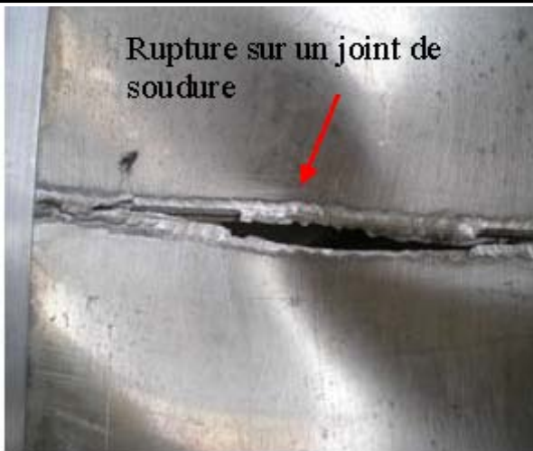
Figure V.18- Rupture du joint de et base de soudure.
