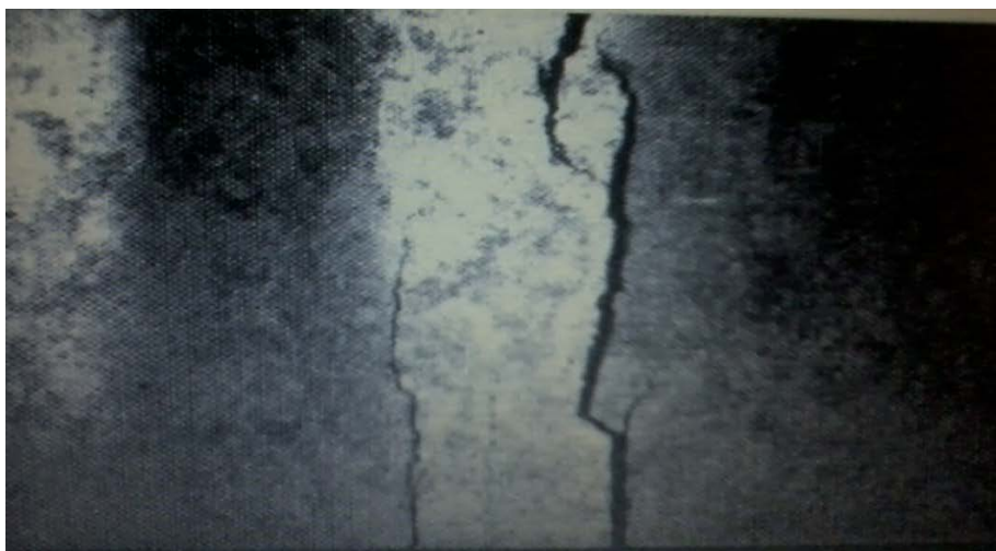
Figure III.7 – Fissure de corrosion sous contrainte propagation électrochimique [14].
