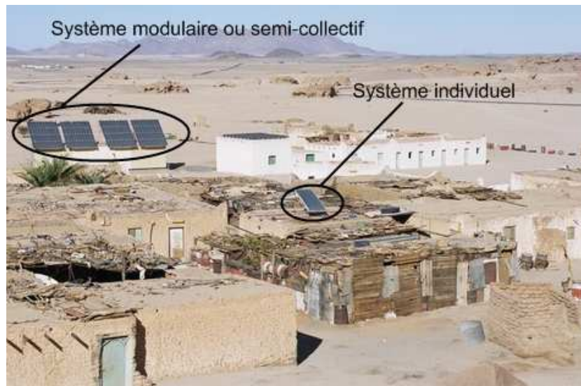
Figure 2.2. Systèmes photovoltaïques individuels et semi-collectifs installés dans un village du programme.
