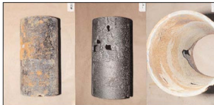
Figure 1.2 : Points de corrosion sur conduites métalliques en fonte [Laplaud et col, 1998].
